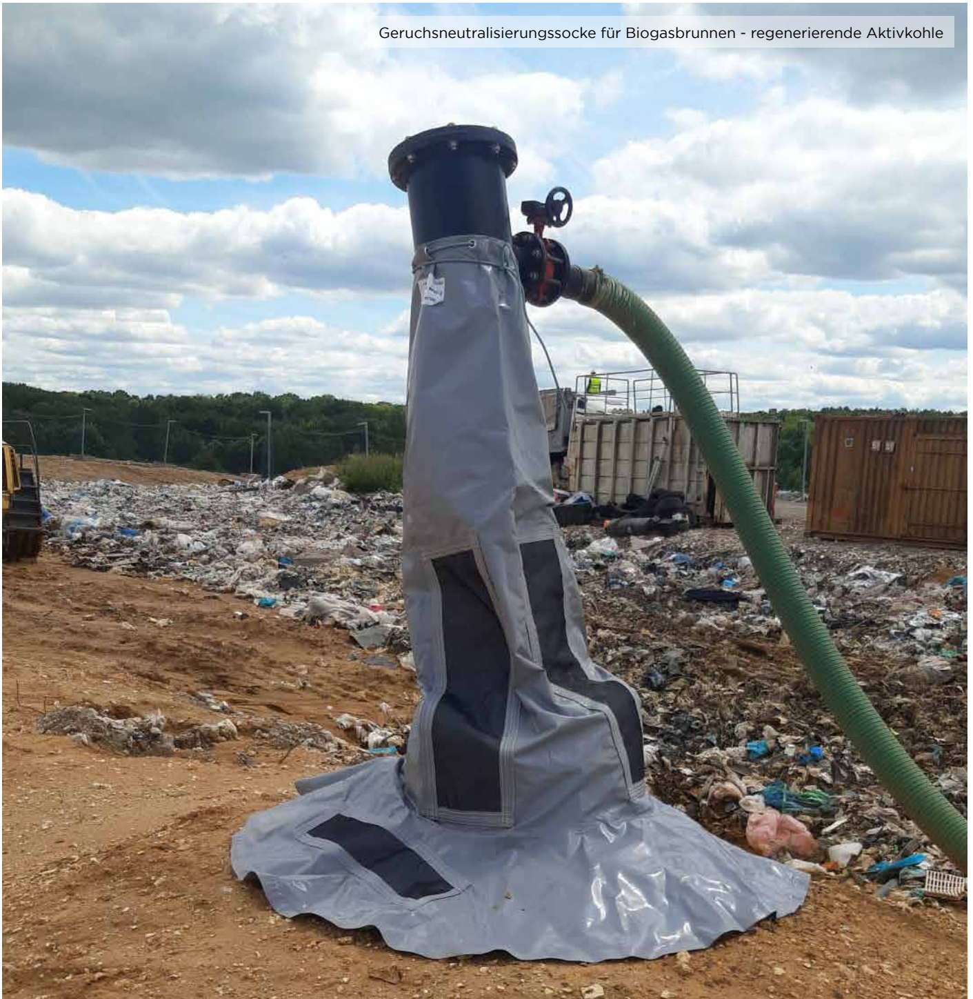
Geruchsneutralisierende Abdeckung mit regenerierender Aktivkohle
