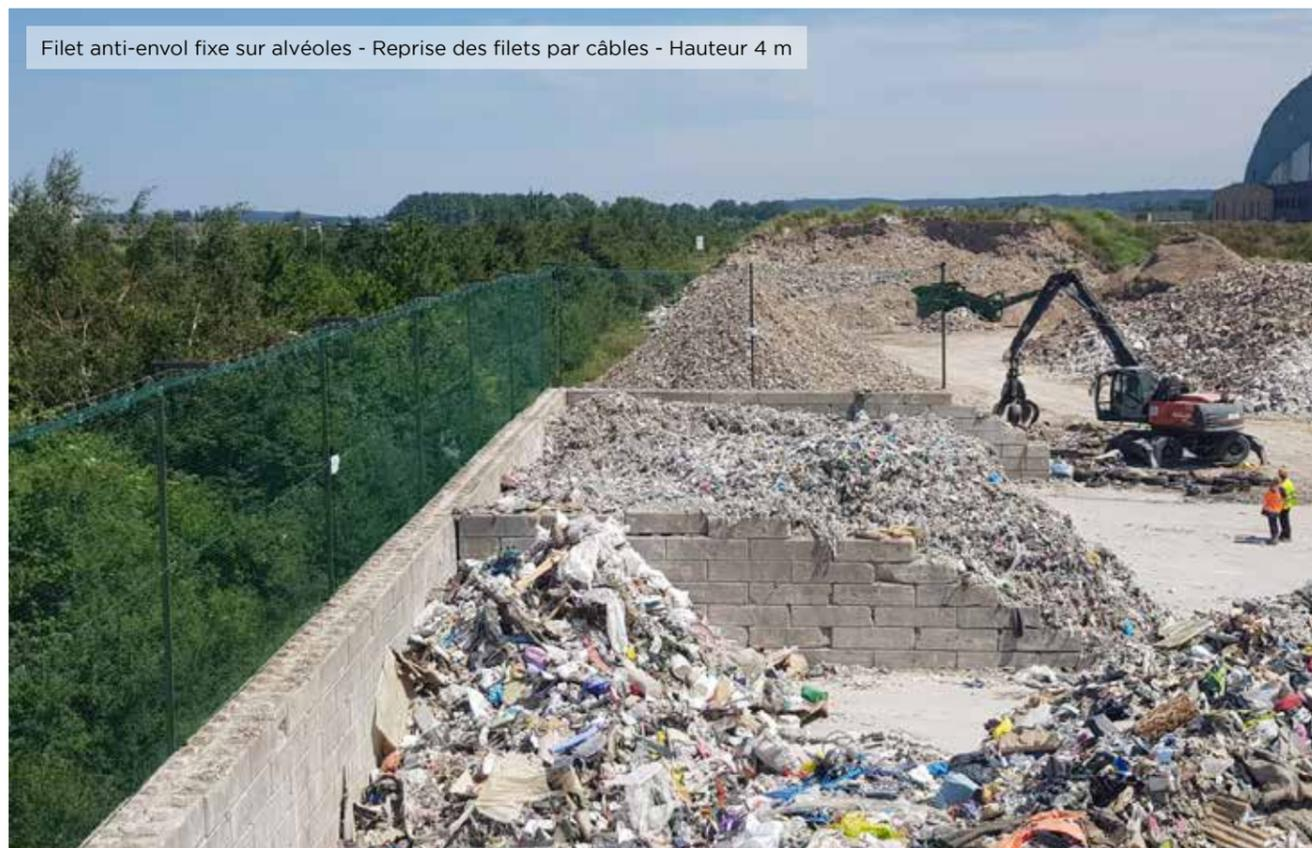
Filet anti-envol fixe sur alvéoles - Reprise des filets par câbles - Hauteur 4 m
