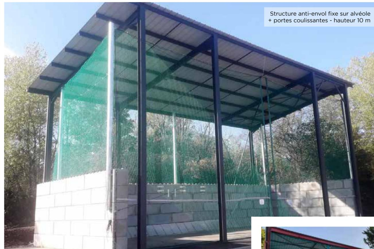
Structure anti-envol fixe sur alvéole + portes coulissantes - hauteur 10 m
