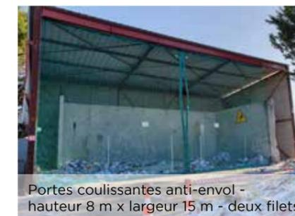
Portes coulissantes anti-envol - hauteur 8 m x largeur 15 m - deux filets
