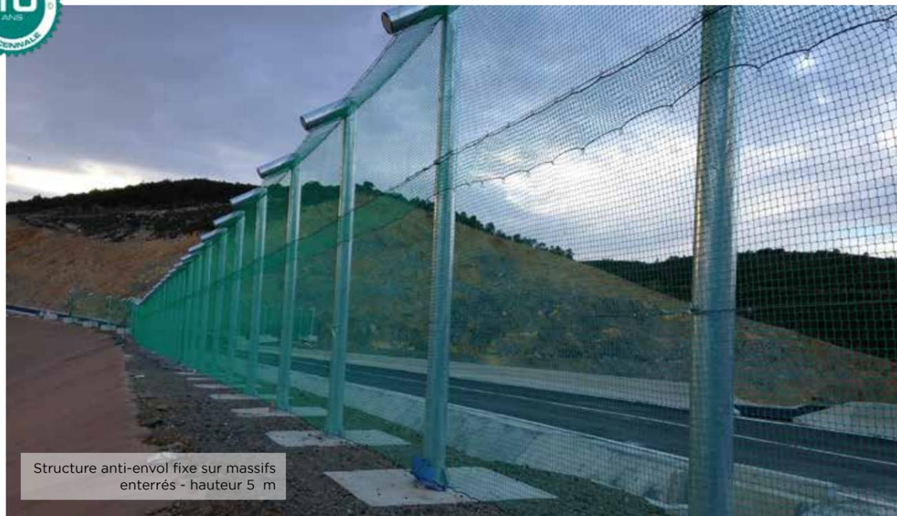
Structure anti-envol fixe sur massifs enterrés - hauteur 5 m
