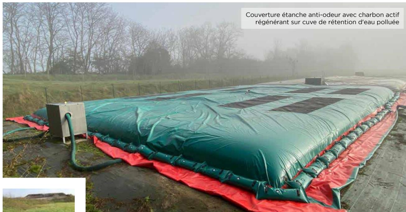
Couverture étanche anti-odeur avec charbon actif régénérant sur cuve de rétention d'eau polluée
