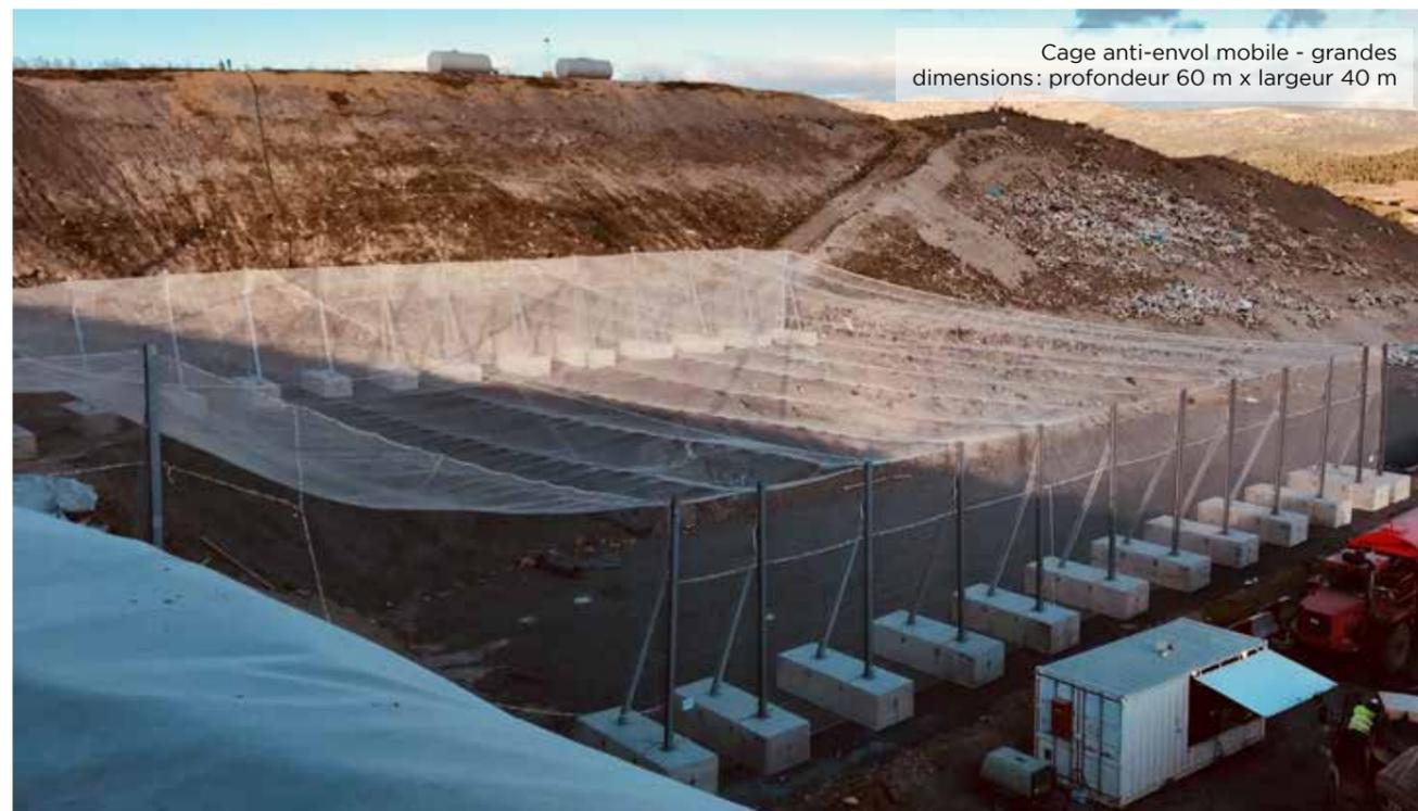
Cage anti-envol mobile - grandes dimensions : profondeur 60 m x largeur 40 m
