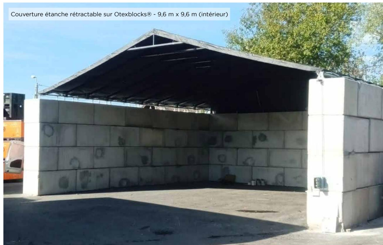
Couverture étanche rétractable sur Otexblocks® - 9,6 m x 9,6 m (intérieur)
