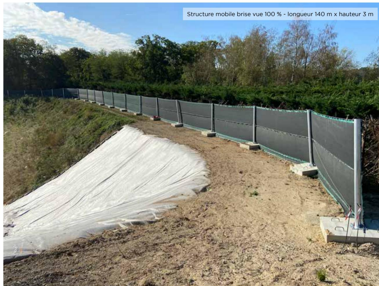
Structure mobile brise vue 100 % - longueur 140 m x hauteur 3 m
