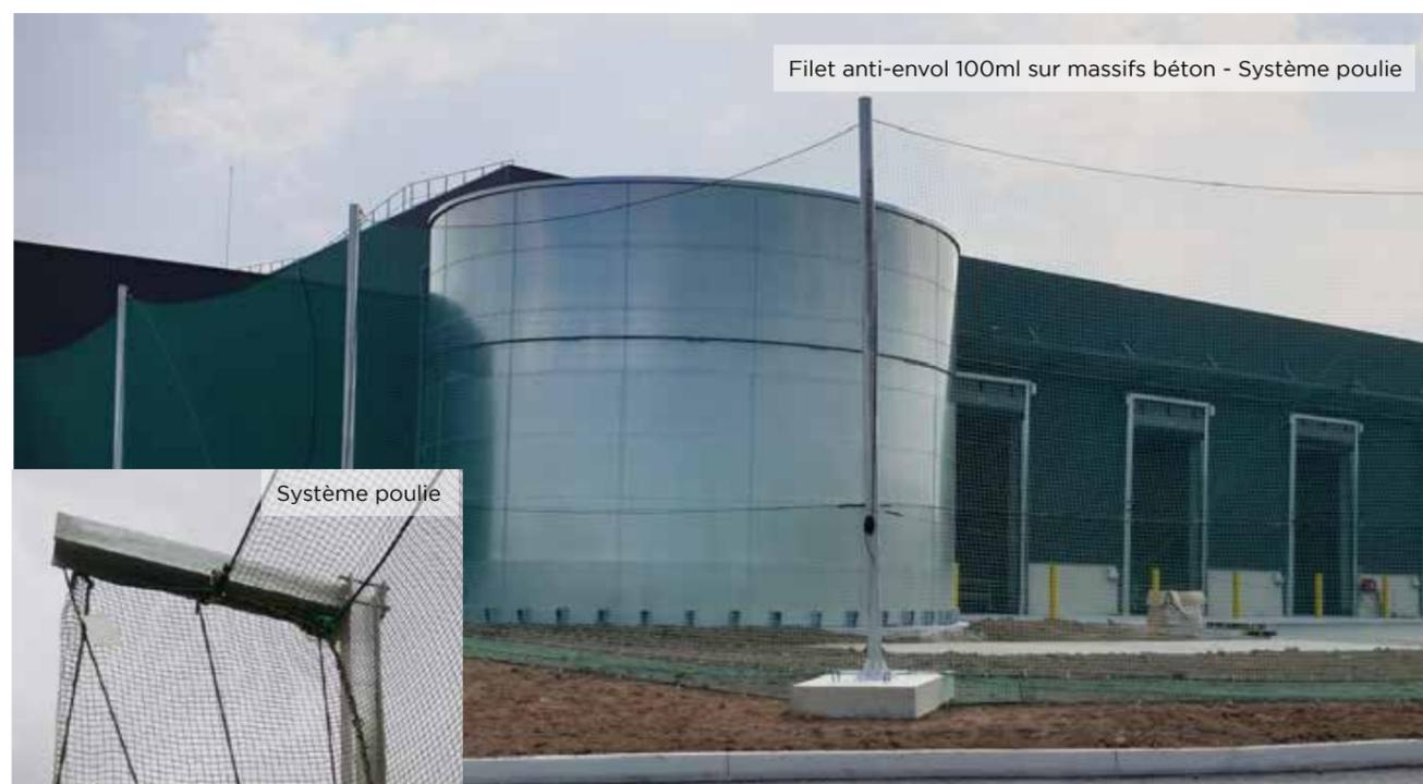
Filet anti-envol 100ml sur massifs béton - Système poulie
