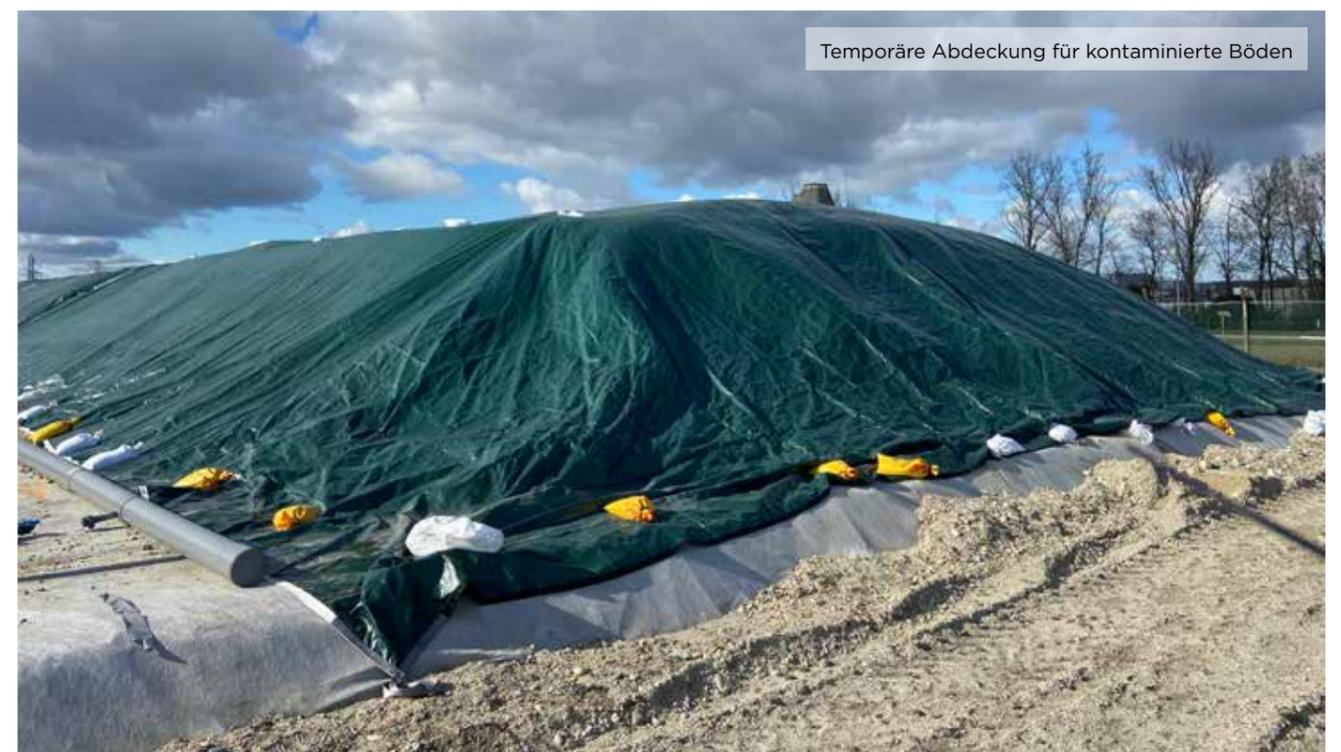
TECHNISCHE GERUCHSNEUTRALISIERENDE PLANE
