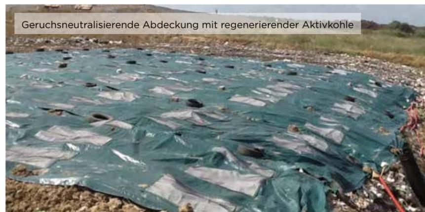
Geruchsneutralisierende Abdeckung mit regenerierender Aktivkohle
