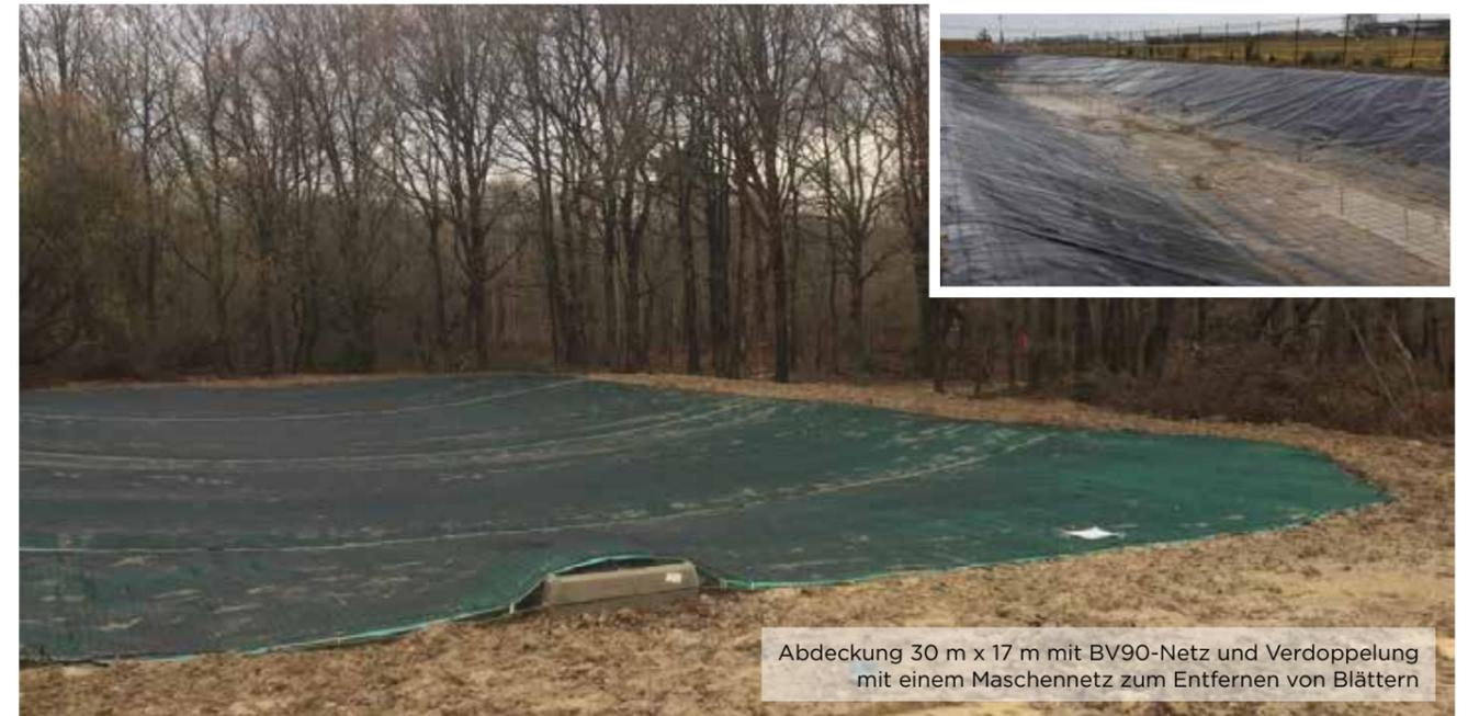
Abdeckung 30 m x 17 m mit BV90-Netz und Verdoppelung mit einem Maschennetz zum Entfernen von Blättern
