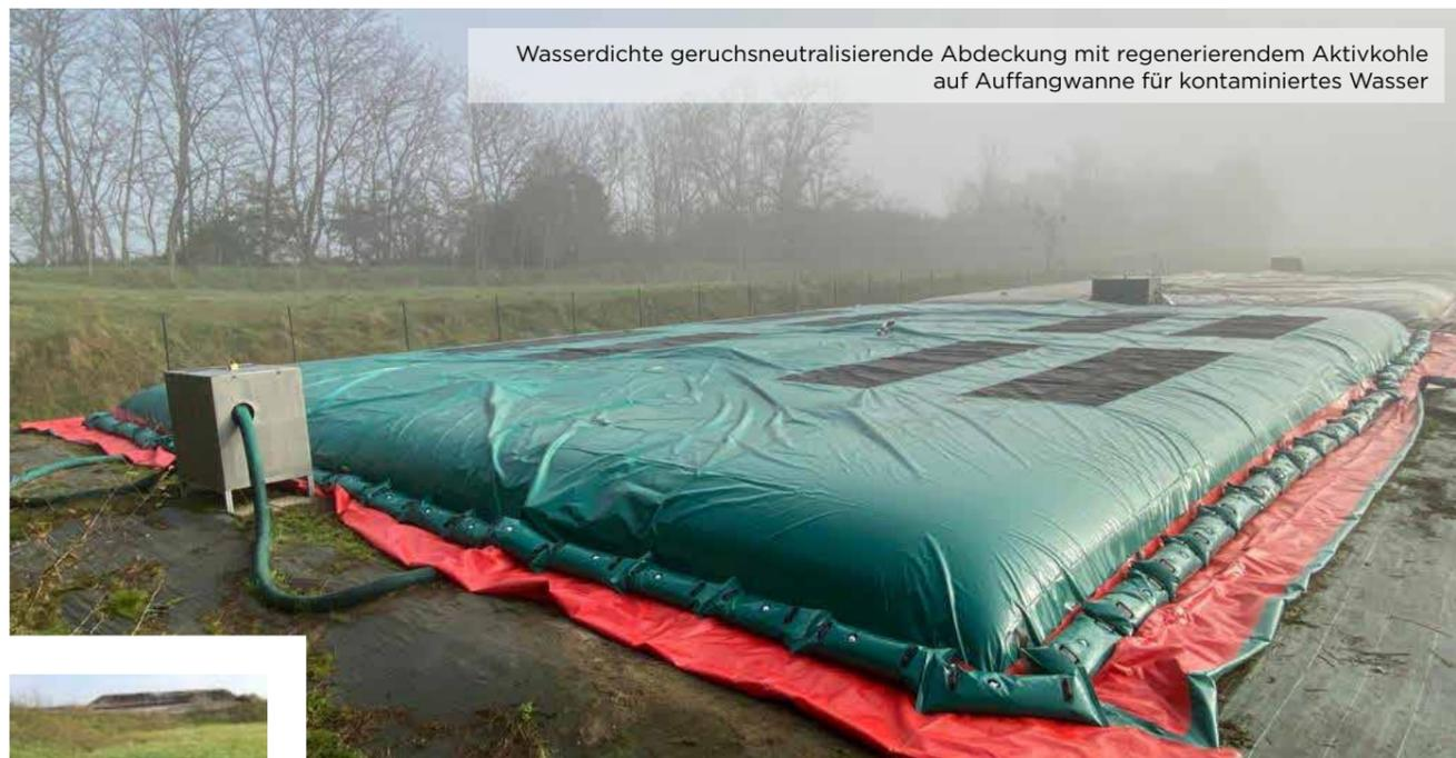
Wasserdichte geruchsneutralisierende Abdeckung mit regenerierendem Aktivkohle auf Auffangwanne für kontaminiertes Wasser
