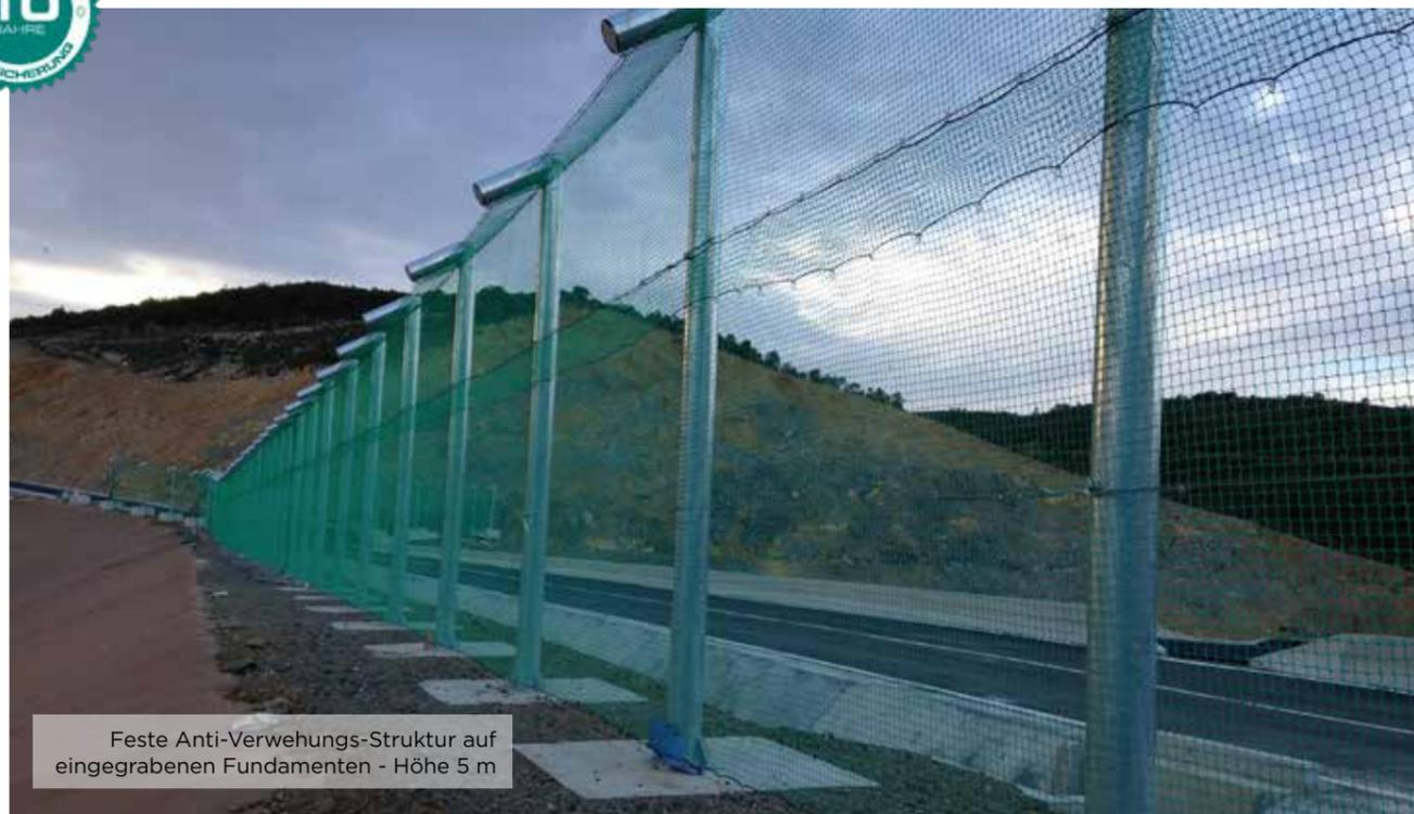
Feste Anti-Verwehungs-Struktur auf eingegrabenen Fundamenten - Höhe 5 m
