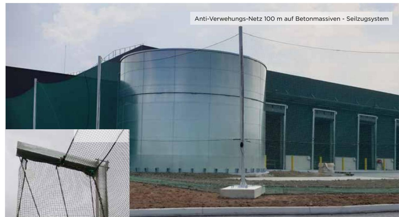
Anti-Verwehungs-Netz 100 m auf Betonmassiven - Seilzugsystem
