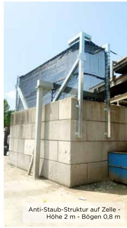
Anti-Staub-Struktur auf Zelle - Höhe 2 m - Bögen 0,8 m
